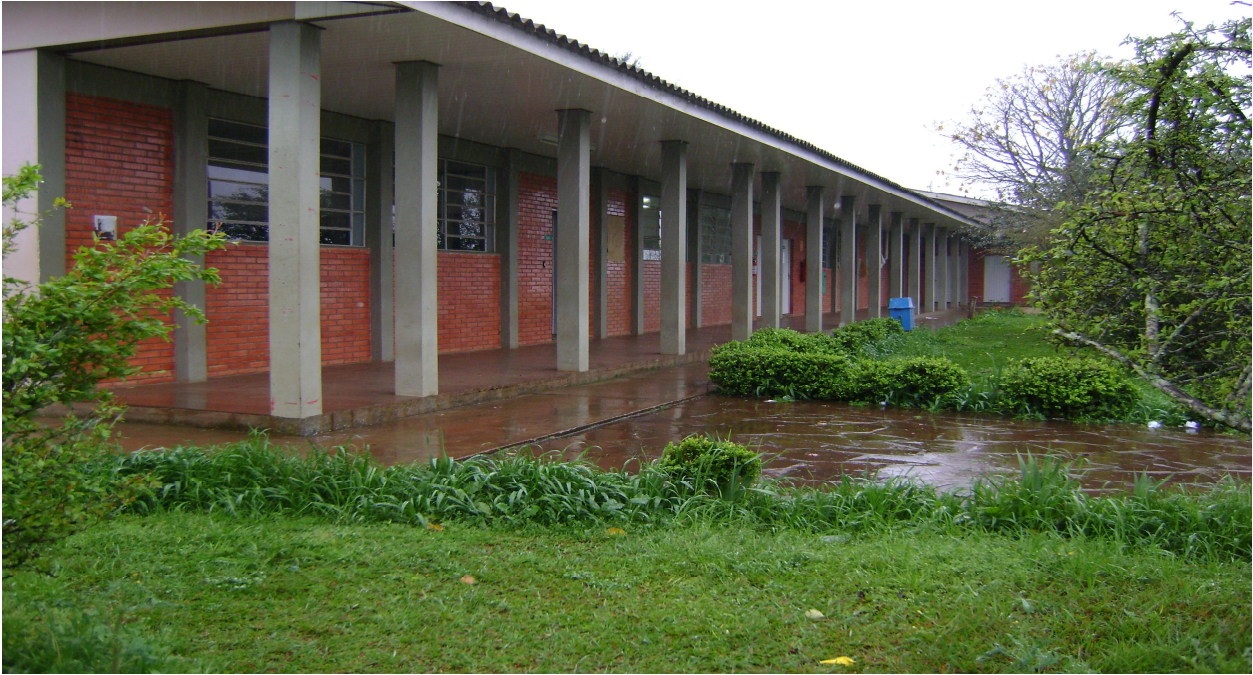
Corredor de salas de aulas.
