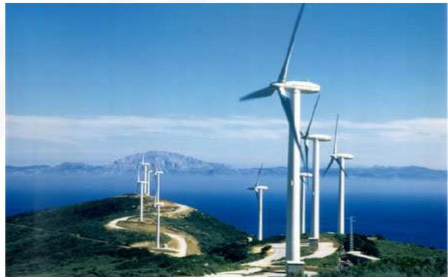
O vento forte pode rodar as lâminas de uma turbina adaptada para o vento (em vez do vapor ou da água é o vento que faz girar a turbina). A ventoinha da turbina está ligada a um eixo central que contém em cima um fuso rotativo. Este eixo chega até uma caixa de transmissão onde a velocidade de rotação é aumentada. O gerador ligado ao transmissor produz energia elétrica.
