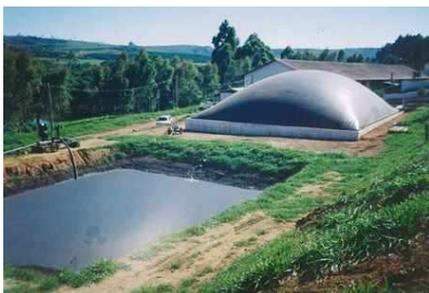
O biogás é um combustível gasoso com um conteúdo energético elevado semelhante ao gás natural, composto, principalmente, por hidrocarbonetos de cadeia curta e linear. Pode ser utilizado para geração de energia elétrica, térmica ou mecânica em uma propriedade rural, contribuindo para a redução dos custos de produção. No Brasil, os biodigestores rurais vêm sendo utilizados, principalmente, para saneamento rural, tendo como subprodutos o biogás e o biofertilizante.
