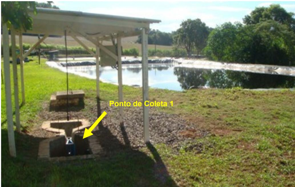
Figura 4.7 – Calha Parshal (Ponto de Coleta 1) e Lagoa de Equalização/Anaeróbica ao fundo.
