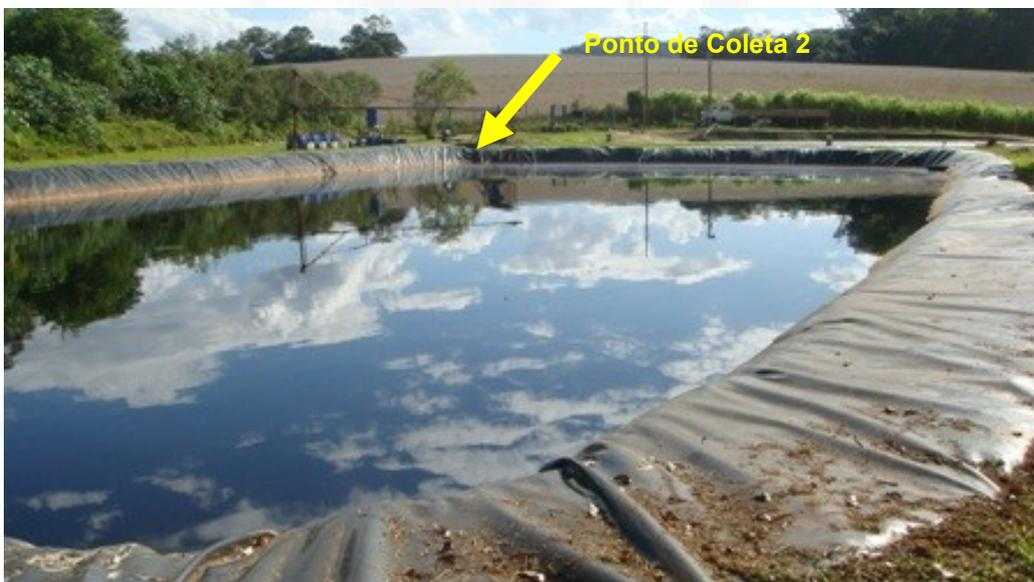
Figura 4.8 – Lagoa de Equalização/Anaeróbica (Ponto de Coleta 2).
