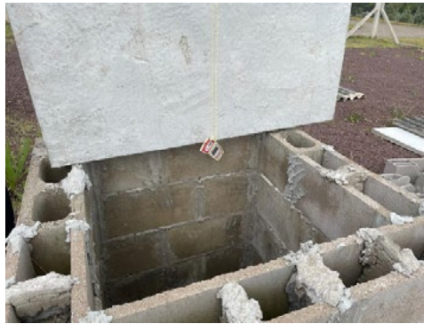
Figura 2. Datalogger já em funcionamento nos protótipos.
