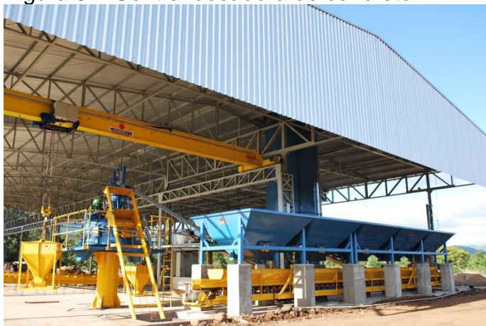
Figura 8 – Central dosadora de concreto
