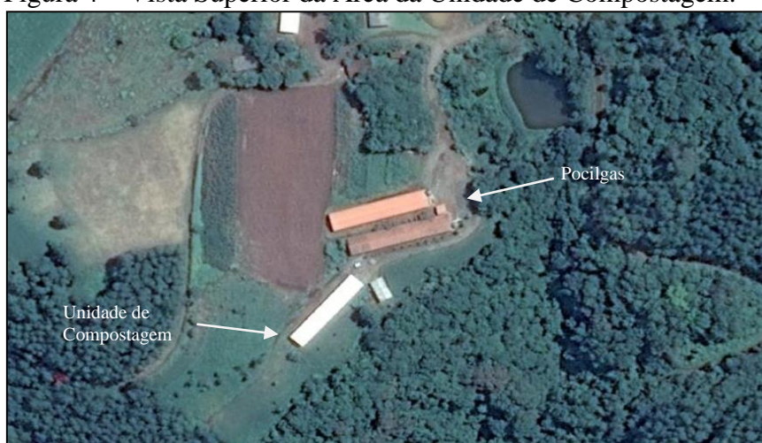
Figura 4 – Vista Superior da Área da Unidade de Compostagem.
