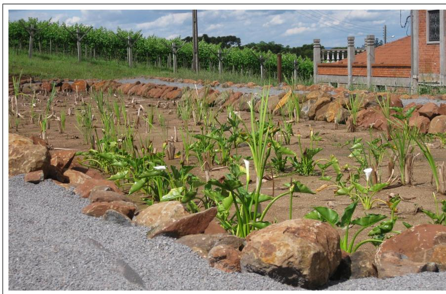
**Figura 4 Vista sistema de tratamento por *wetland construído*, sistema subsuperficial, com plantas em desenvolvimento.**
