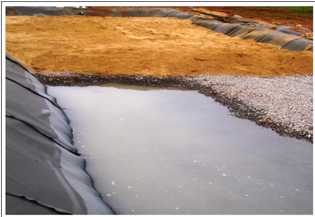
Figura 17 Vista do *wetland construído* mostrando a disposição das camadas de substrato, com fase concluída sem lâmina de água aparente.
