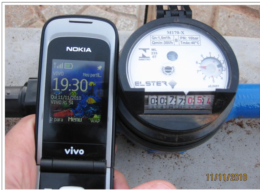
**Figura 26** Coleta de dados de vazão de entrada e saída, mostrando horário de coleta e leitura do hidrômetro.
