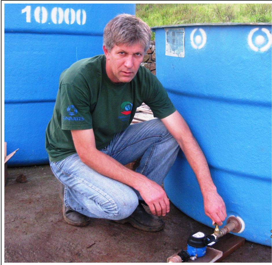
**Figura 23 Medidor de vazão (hidrômetro) instalado na entrada do *wetland construído* para leitura da vazão.**
