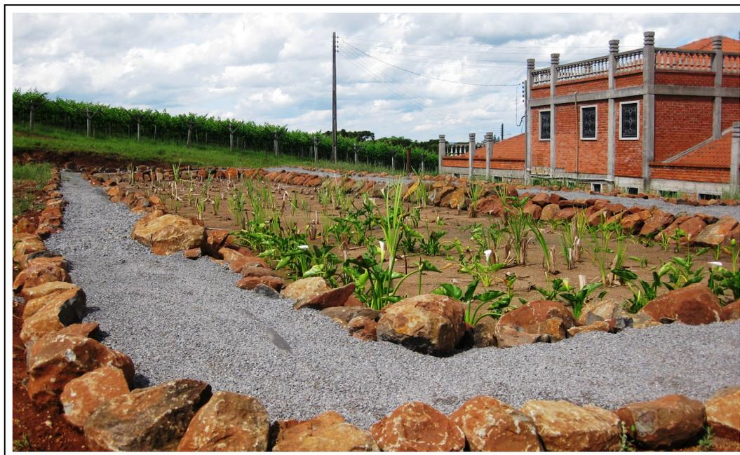
Figura 18 *Wetland construído* com plantas sem lâmina de água aparente, local do experimento.
