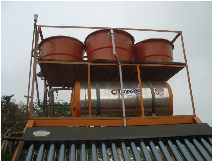
**Figura 15 Reservatórios de 100 L (não térmicos) e reservatório térmico de 200 L**
