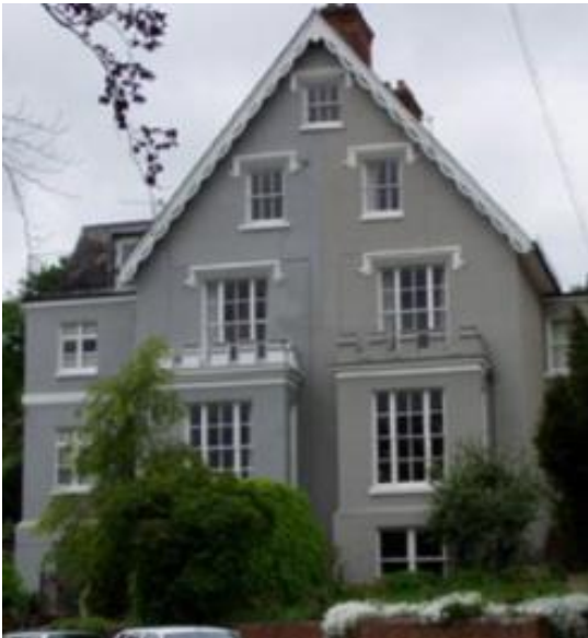
Figura 14 – Edifício residencial com 5 pavimentos, feito com método taipa de pilão, localizada na Inglaterra.
