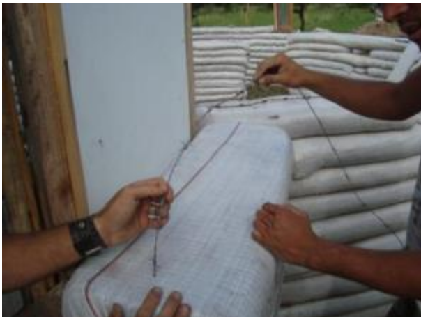
Figura 21 – Colocação de arame farpado para junção das fiadas.
