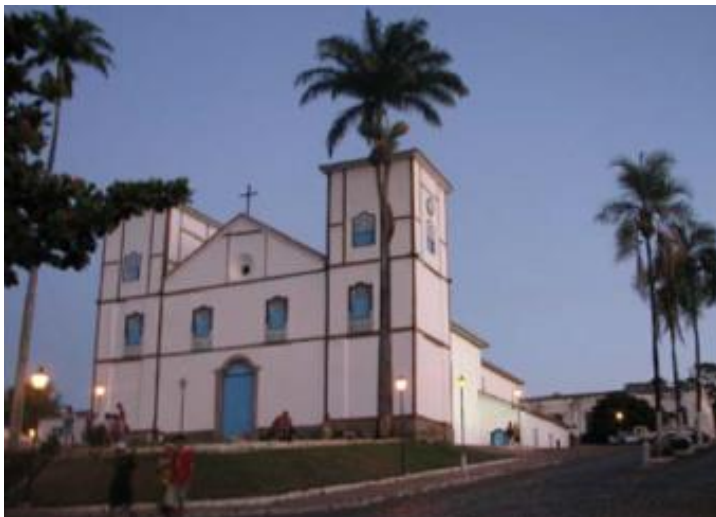
Figura 13 – Igreja executada pelo método taipa de pilão.
