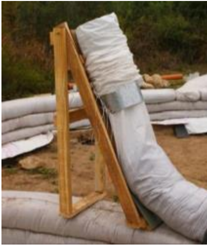
Figura 22 – Cavalete para execução das fiadas no método de superadobe.
