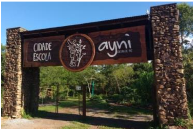
Figura 27 – Entrada da Cidade Escola Ayni.
