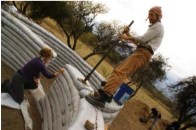
Figura 20 – Pilão para compactação das fiadas de superadobe.
