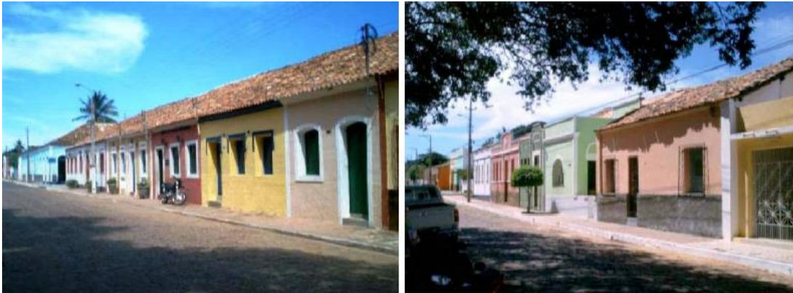
Figura 18 – Casas antigas em adobe, Piauí.
