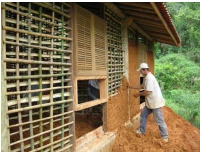
Figura 9 – Execução do método pau-a-pique.
