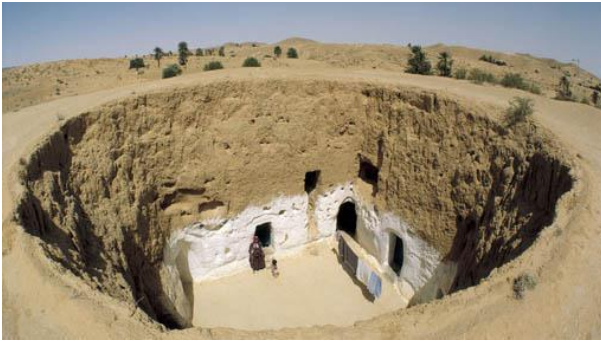
Figura 6 – Construção na forma vertical pelo método de terra escavada
