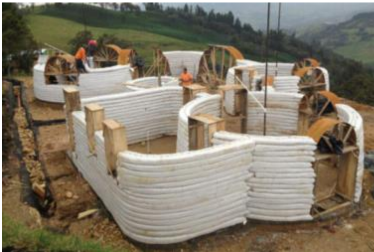
Figura 23 – Edificação sendo executada pelo método de superadobe.
