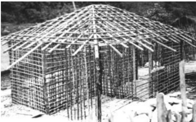
Figura 8 – Trama utilizada para estrutura do pau-a-pique.
