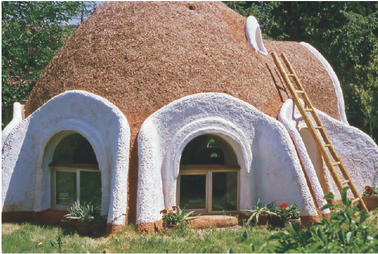
Figura 25 – Construção com paredes e cobertura com método de hiperadobe.
