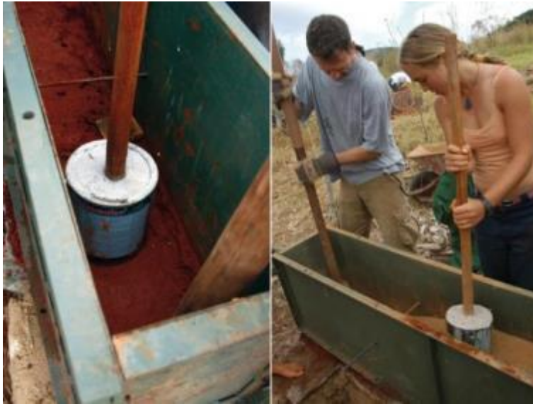
Figura 16 – Execução do método taipa de pilão.
