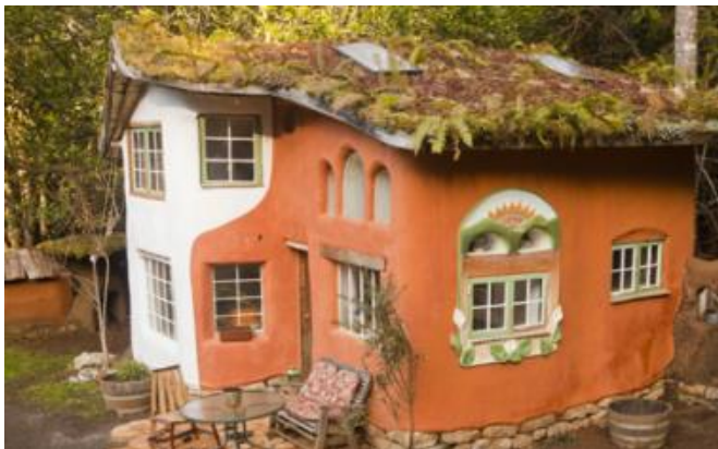
Figura 12 – Residência executada pelo método COB.
