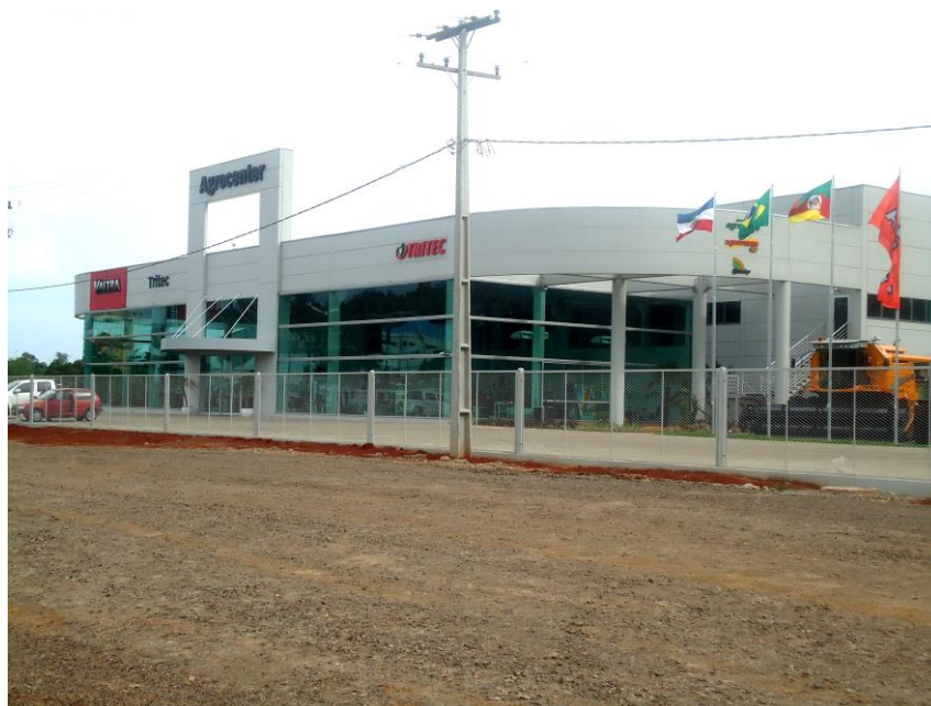
Figura 2 – Fachada da empresa Tritec
