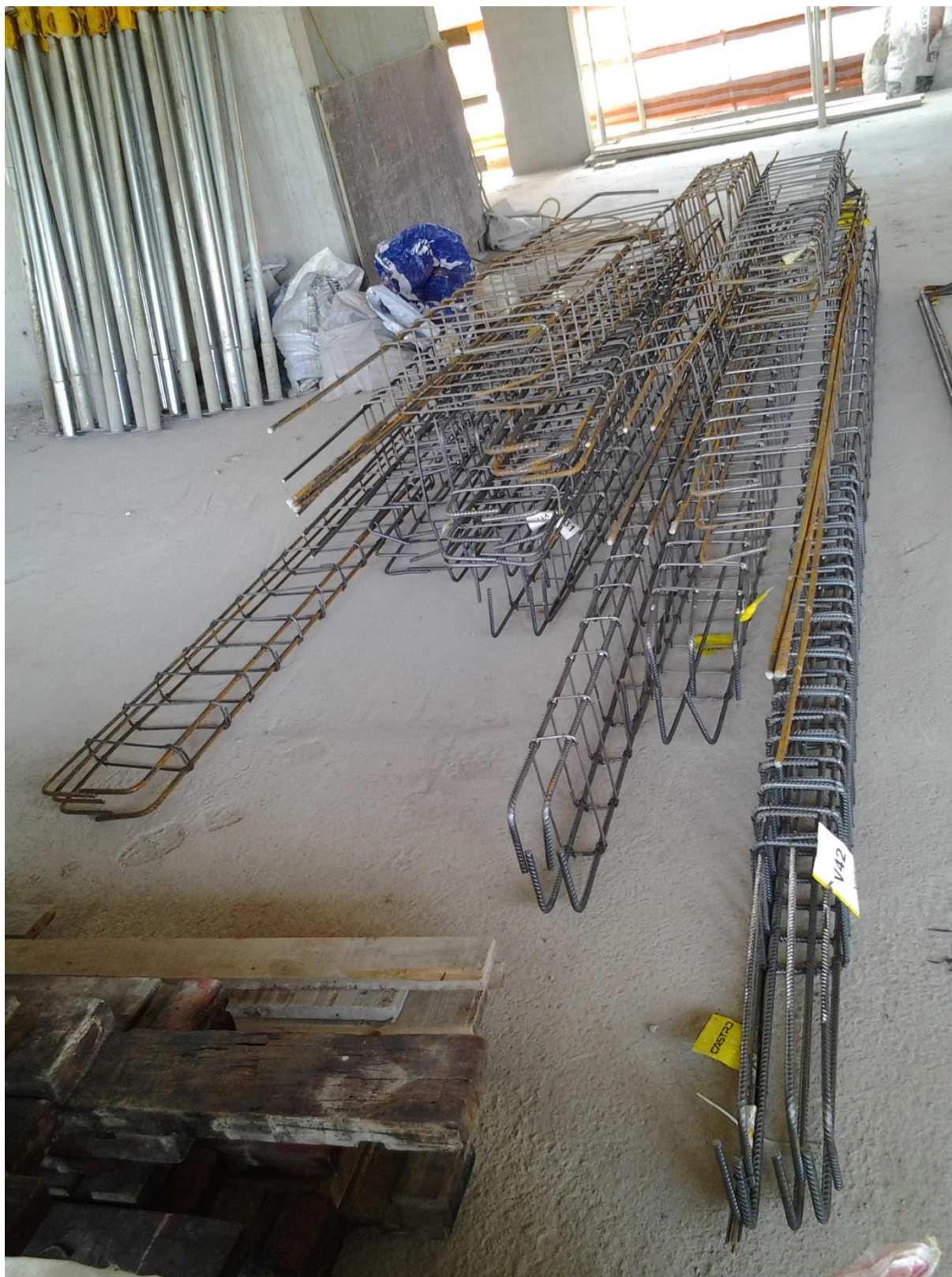
Figura 5 – Fornecimento de aço pré-armado
