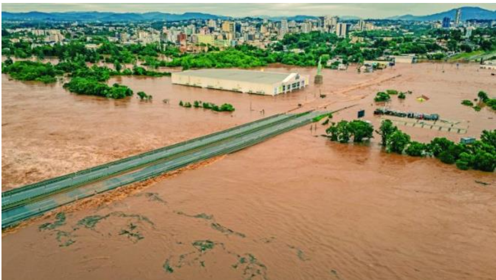
Figura 9 - Ponte na BR 386
