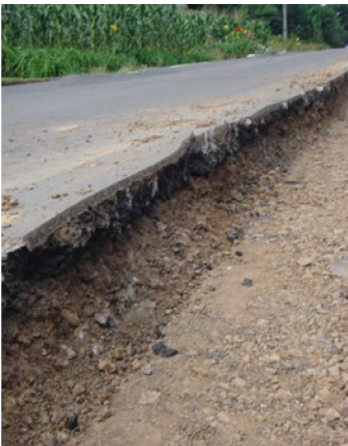
Figura 7. Corte vertical do pavimento
