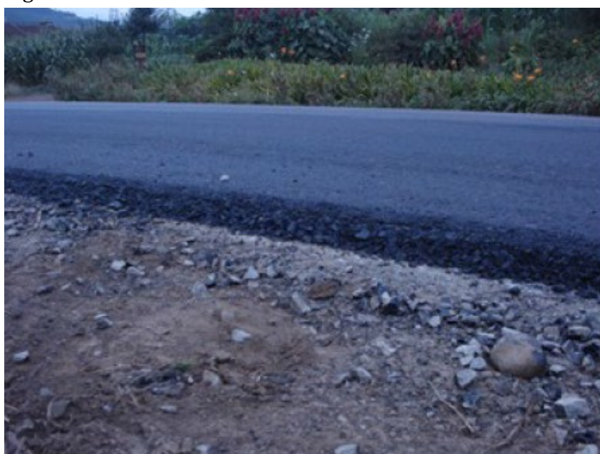
Figura 9. Camada de revestimento betuminoso
