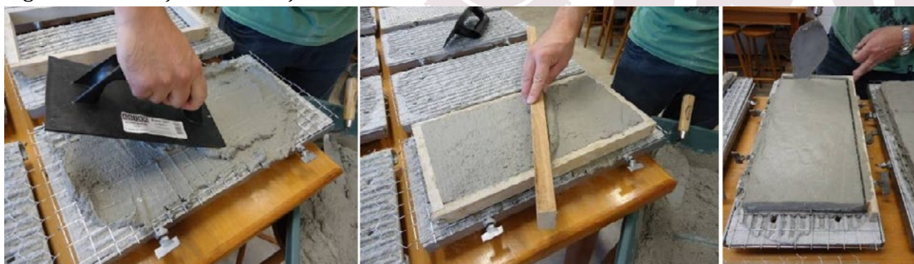
Figura 8 – Execução do emboço.
