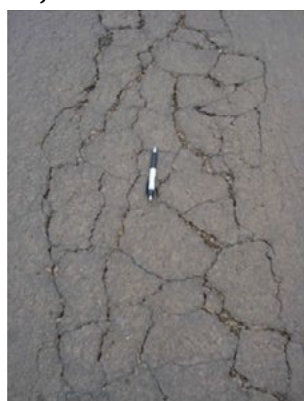
a) Trinca “couro de jacaré”
