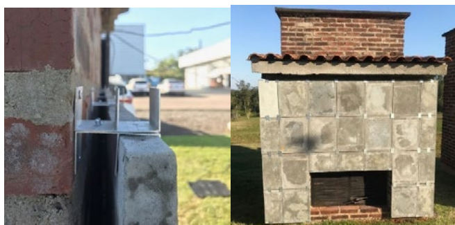
Figura 3. Sistema de fixação das placas
