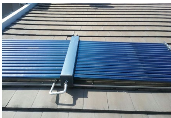
Figura 1, coletor solar a vácuo 30 tubos
