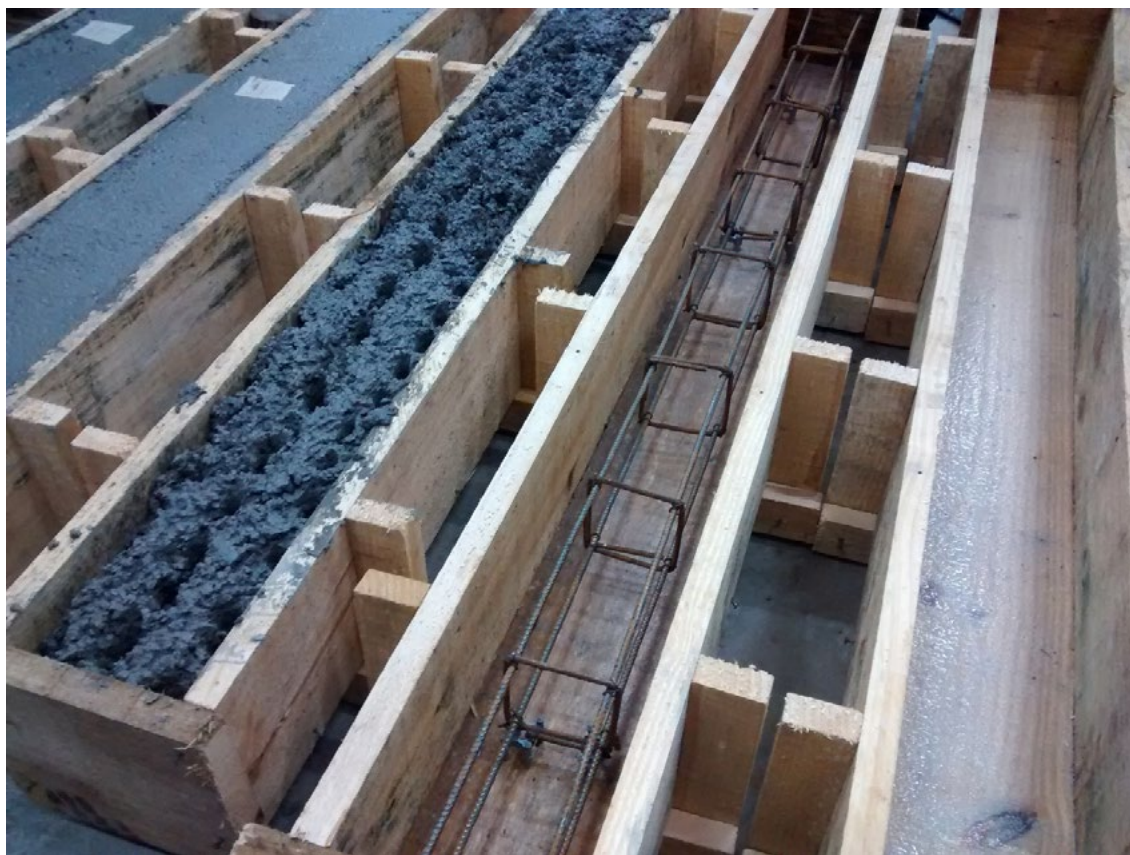
Figura 1. Concretagem e fôrmas das vergas.
