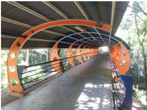
Figura 1. Passarela da Univates.
