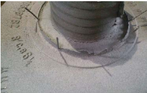
Figura 4: Peça defeituosa evidenciando a trinca
