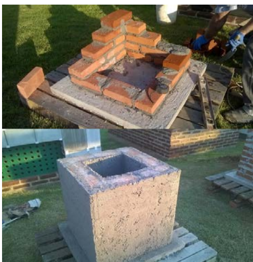
Figura 1. Assentamento de blocos maciços e emboço interno e externo do protótipo C.
