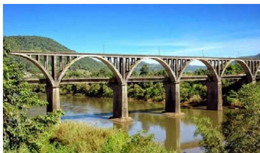
Imagem 1 – Ponte Rodoferroviária Brochado da Rocha
