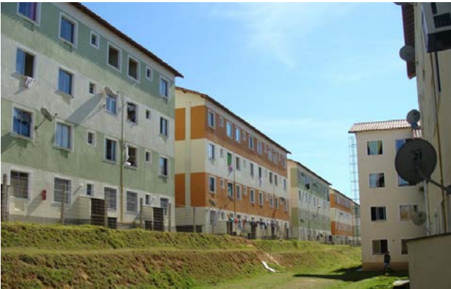
Figura 9 – Vista dos condomínios do RJ
