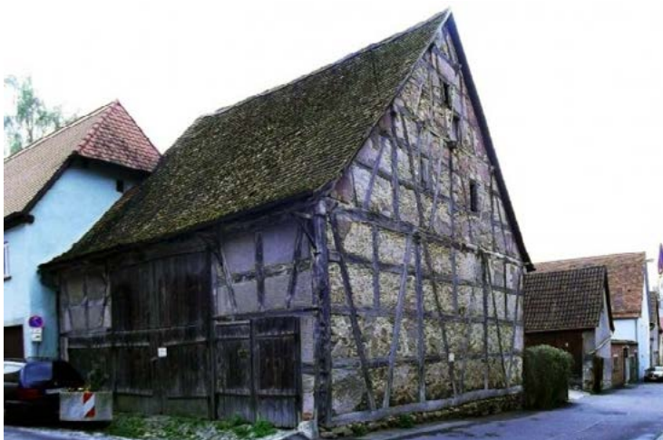
Figura 1 – Edificação enxaimel em Rothenburg ob der Tauber , Alemanha.
