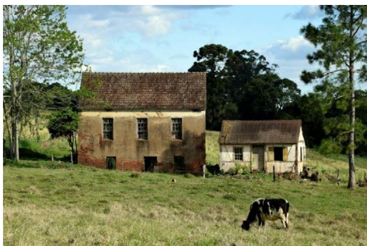
Figura 2 – Edificações históricas de Santa Clara do Sul.
