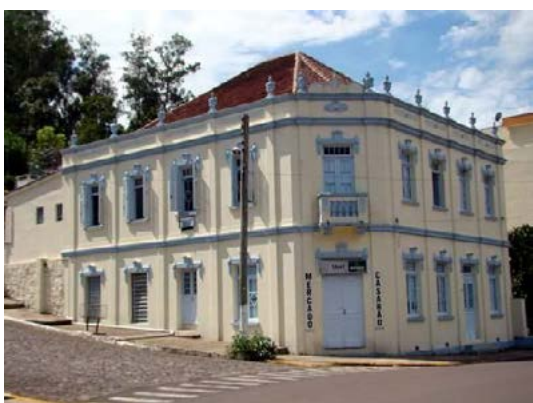
Imagem 11 – Prédio do Mercado Casarão
