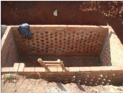
Figura 3. Construção de um sumidouro de acordo com as normas de uma cidade do Vale do Taquari
