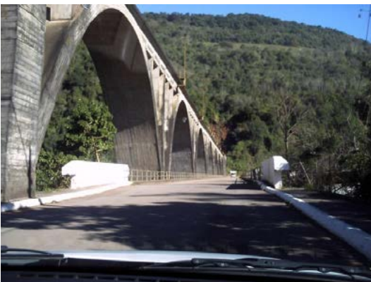
Figura 4: Viaduto Ferreo sobre o Rio Taquari - Muçum/RS
