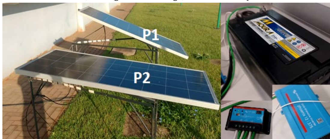
Figura1: Estrutura metálica móvel de suporte das placas fotovoltaicas p1 e p2, uma bateria estacionaria de 220Ah, um regulador de carga, e um inversor (FONTE: OS AUTORES).
