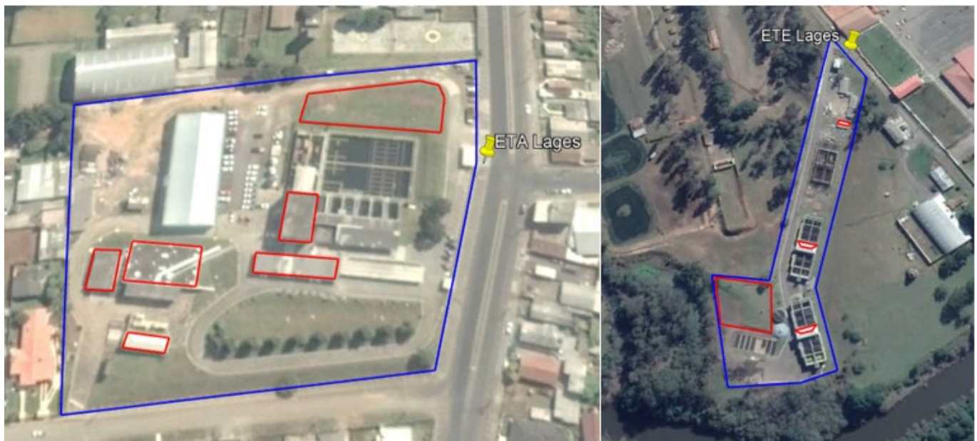
Figura 1 – Locais de instalação dos módulos FV, delimitados em vermelho.
