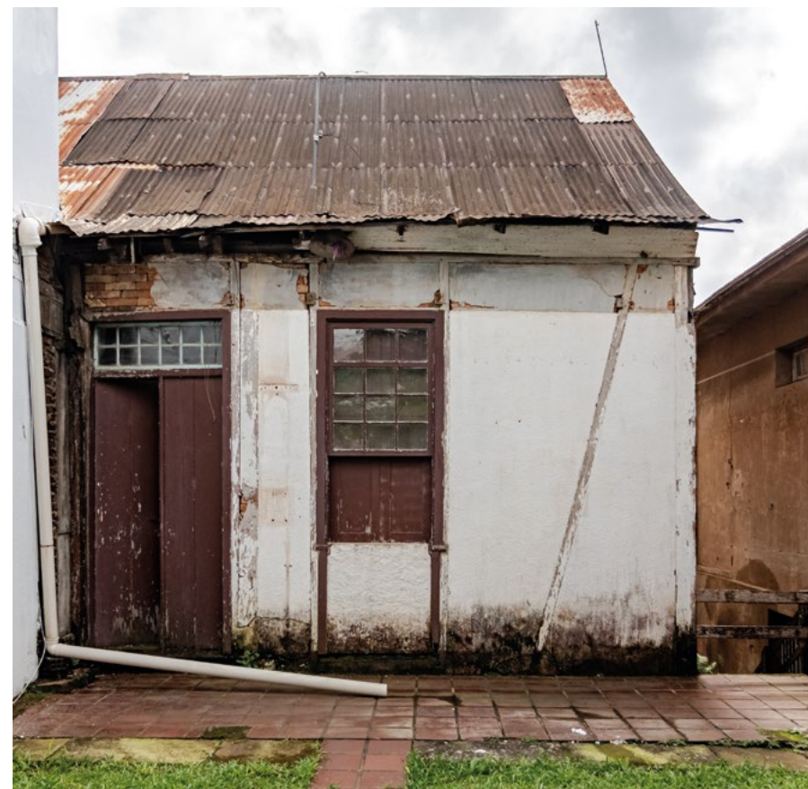
Figura 111. Edificação Enxaimel, no município de Santa Clara do Sul/RS. Fonte: Artur Pretto, 19 de maio de 2019.
