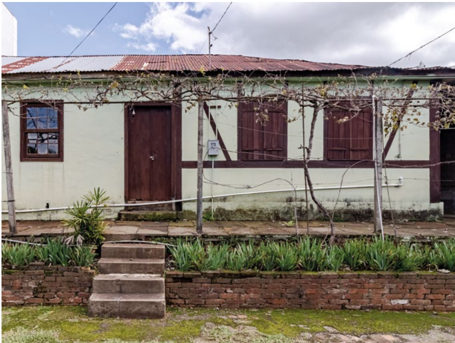
Figura 24. Edificação Enxaimel, no município de Santa Clara do Sul/RS. Fonte: Artur Pretto, 19 de maio de 2019.
