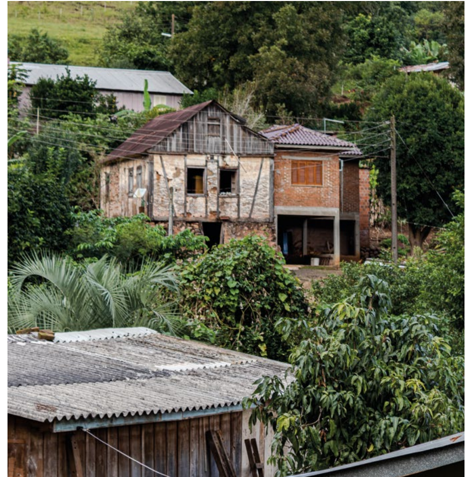
Figura 23. Edificação Enxaimel, no município de Santa Clara do Sul/RS. Fonte: Artur Pretto, 19 de maio de 2019.
