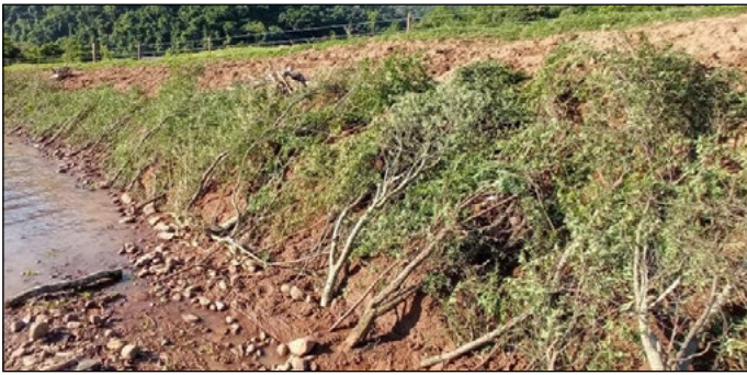
Figura 7: Esteira viva sendo montada para proteção do talude fluvial em local sem correnteza
