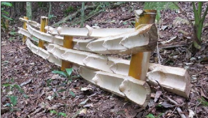
Figura 5: Entrançado com bambu aplicado para diminuir a velocidade do fluxo da água e contenção de processos erosivos, aplicada em talude seco
