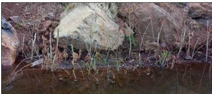
Figura 11: Enrocamento vivo aplicado na proteção de talude fluvial com estacas de Phyllanthus sellowianus em margem de rio
