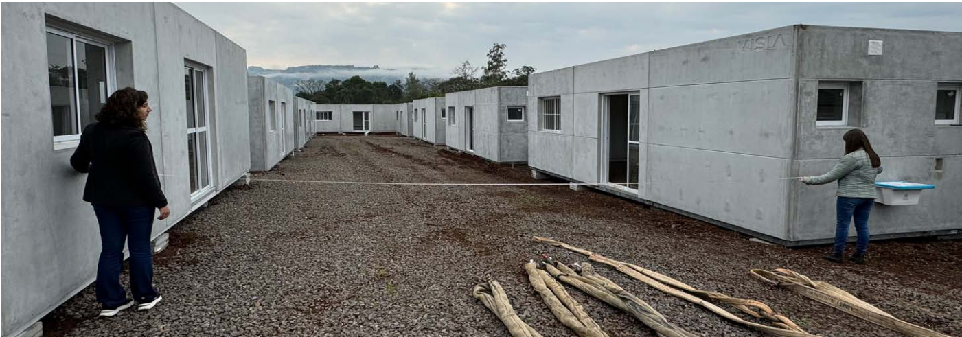
Acompanhamento da instalação dos residências provisórias no município de Encantado.
