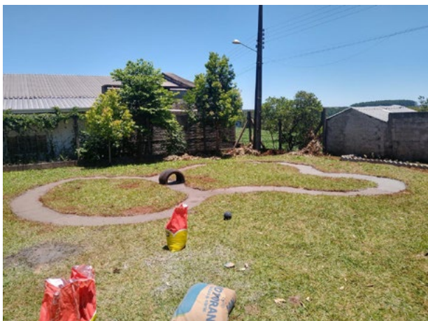
Fotografia 7 – Execução de pista de concreto
