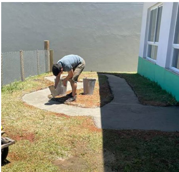
Fotografia 4 – Execução de pista de concreto
