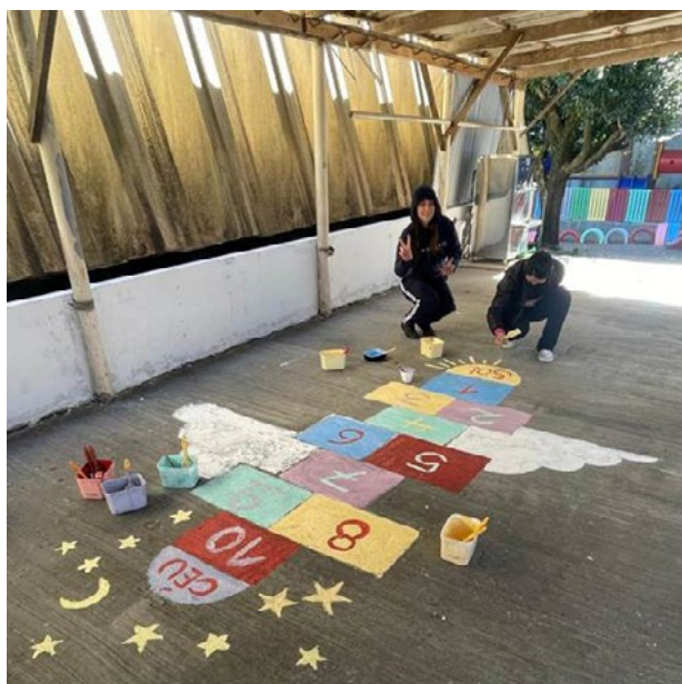
Fotografia 13 – Piso executado e com pinturas
