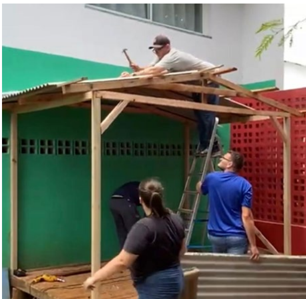
Fotografia 3 – Construção de casinha
