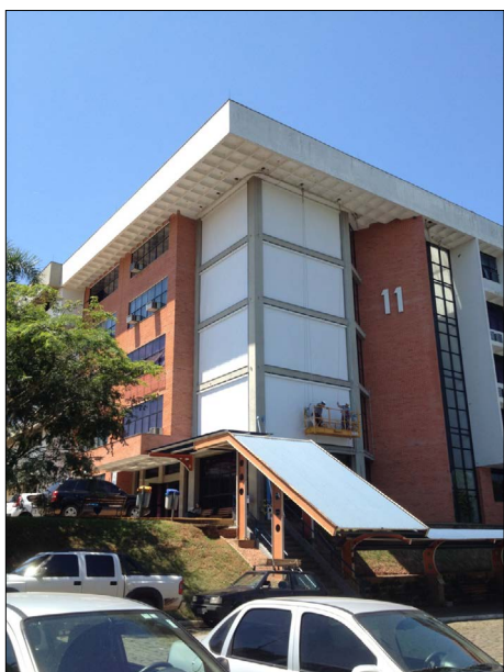
Figura 4 – Imagem externa do prédio com fachada norte e oeste com brise
