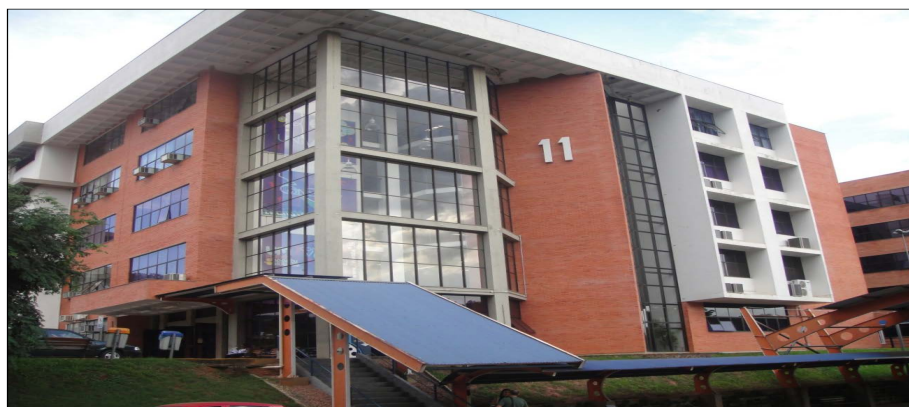
Figura 2 – Imagem externa do prédio com fachada norte e oeste sem brise
