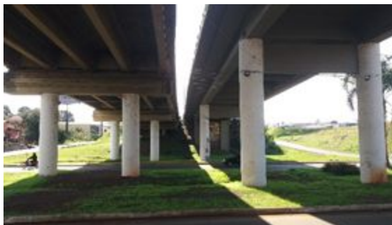
Espaço 4: Pilares do canteiro central dos viadutos da BR 386 sobre a rua Bento Rosa.
