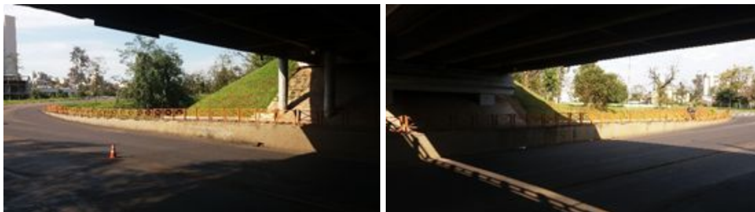
Espaço 2: Mureta leste da av. Alberto Pasqualini sob o viaduto da BR 386.
