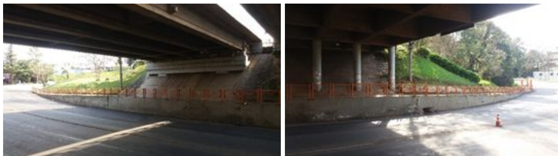
Espaço 1: Mureta oeste da av. Alberto Pasqualini sob o viaduto da BR 386
