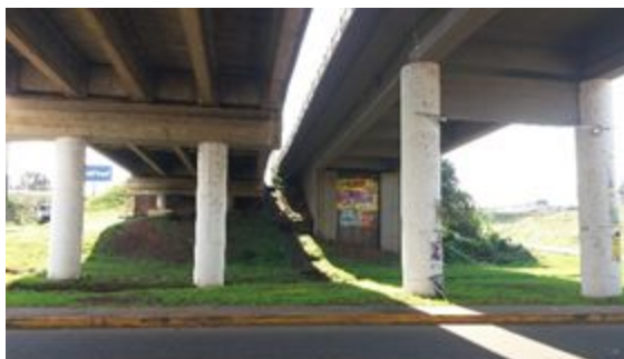
Espaço 3: Cabeceira e pilares do lado norte dos viadutos da BR 386 sobre a rua Bento Rosa
