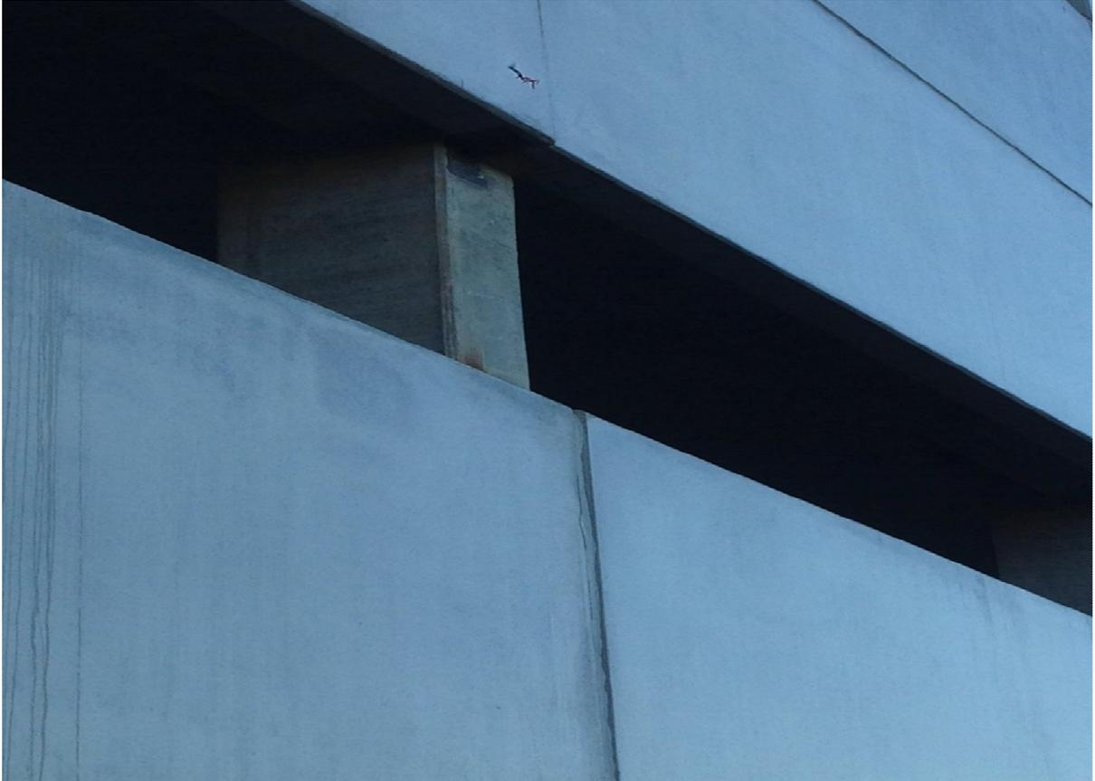
Detalhe das placas unidas por ligante e posicionadas por fora do pilar.
