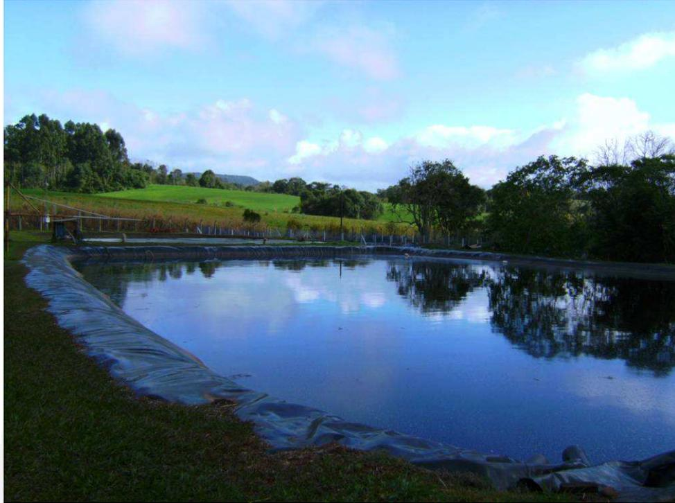
FIGURA 3 - Lagoa anaeróbia da ETE do aterro sanitário de Lajeado
